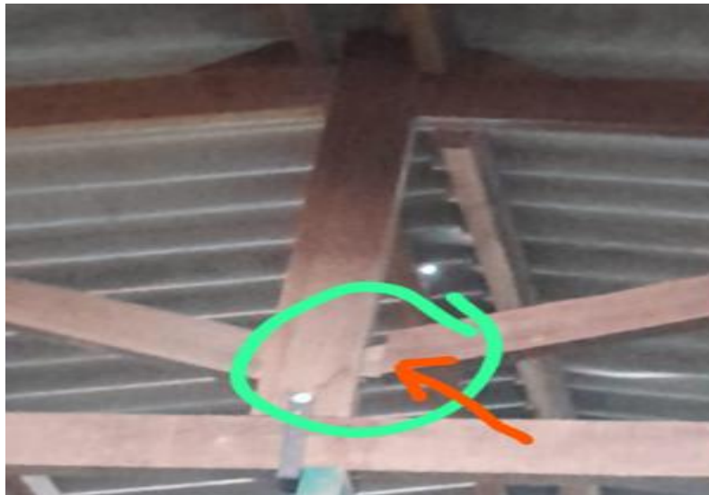
Figura 2: Desencaixe entre peças no nó
